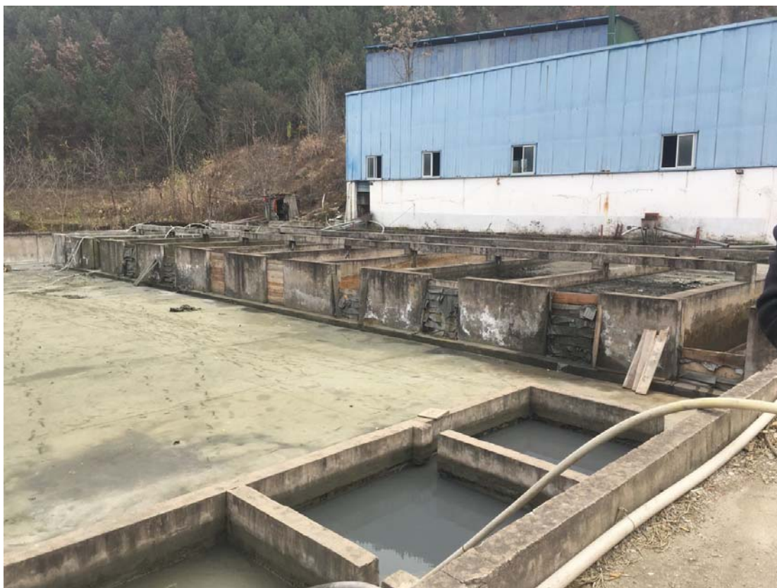
精矿渗滤水收集池
