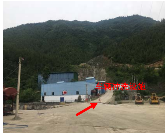
车辆冲洗设施
