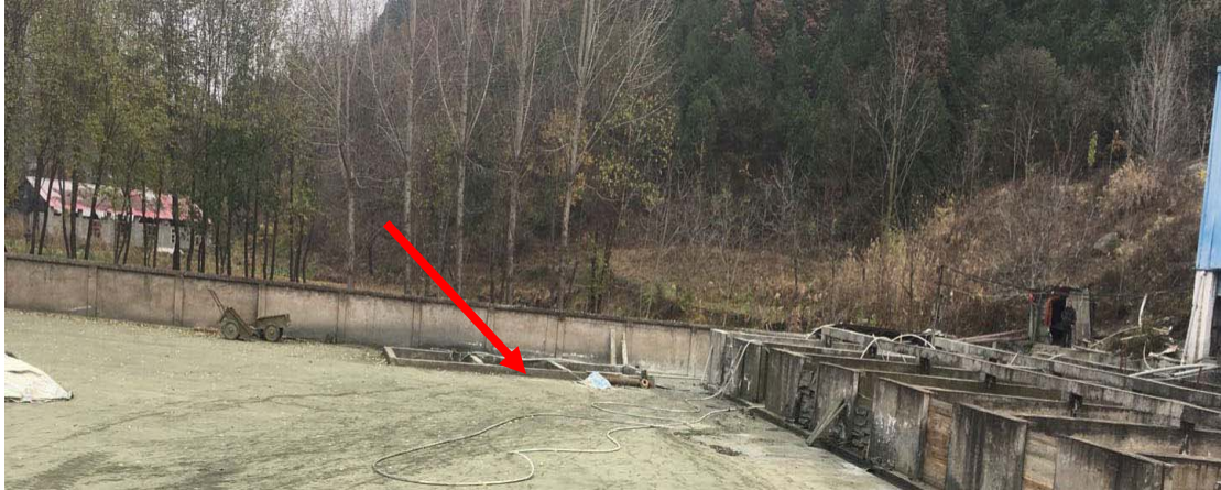
初期雨水收集池
