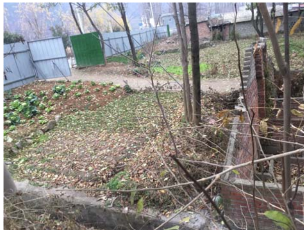
地埋式污水处理设施
