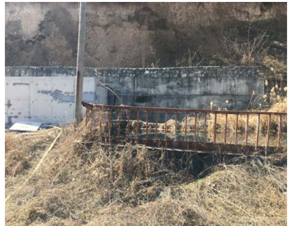
尾矿库排水涵洞出口东侧高位水池
