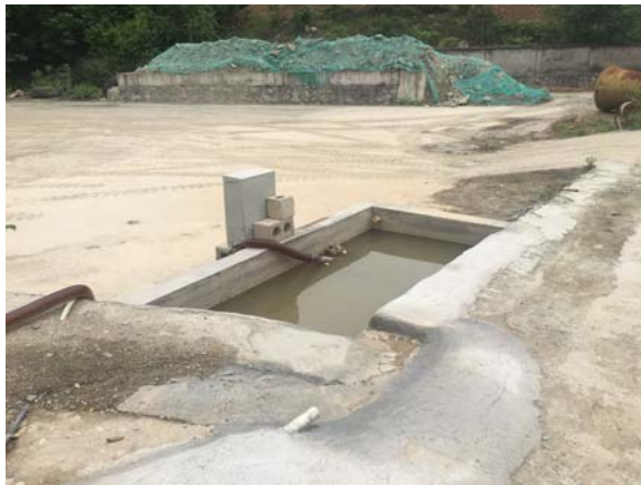
厂区门洗车废水收集池
