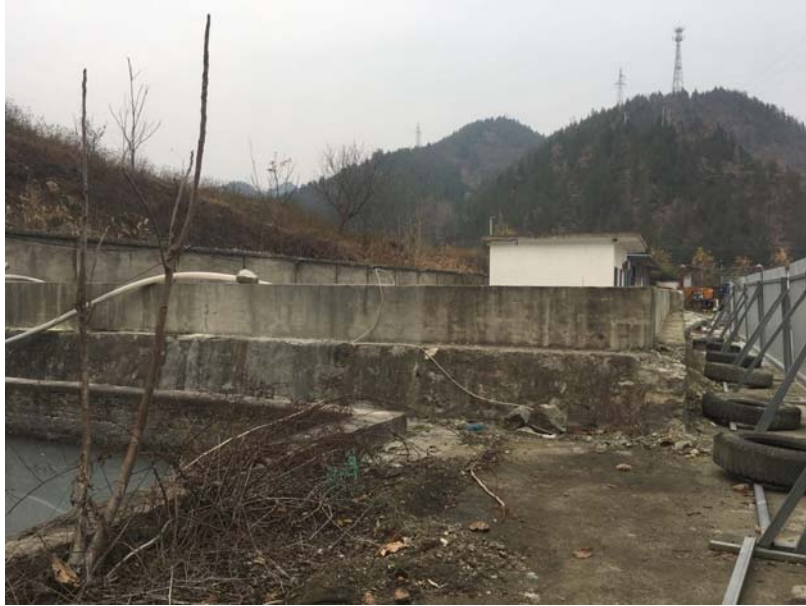
选厂东侧高位水池
