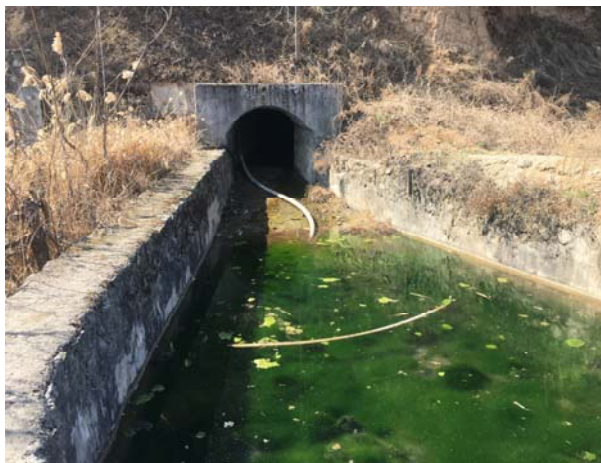
排水涵洞出口处消力水池
