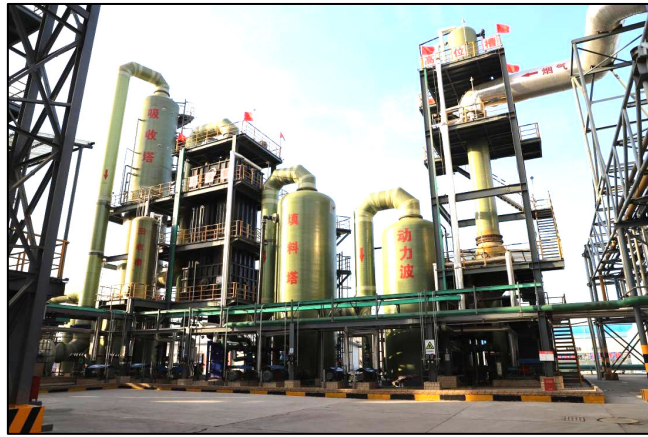
阳极炉烟气脱硫脱硝技术改造工程施工照片
