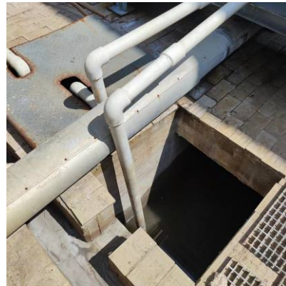
废液收集池和压滤水收集池
