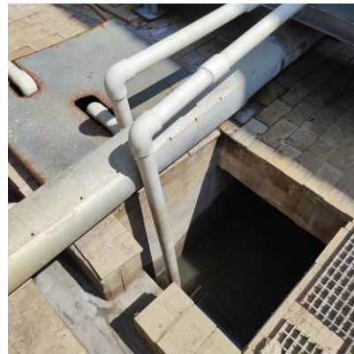
废液收集池和压滤水收集池
